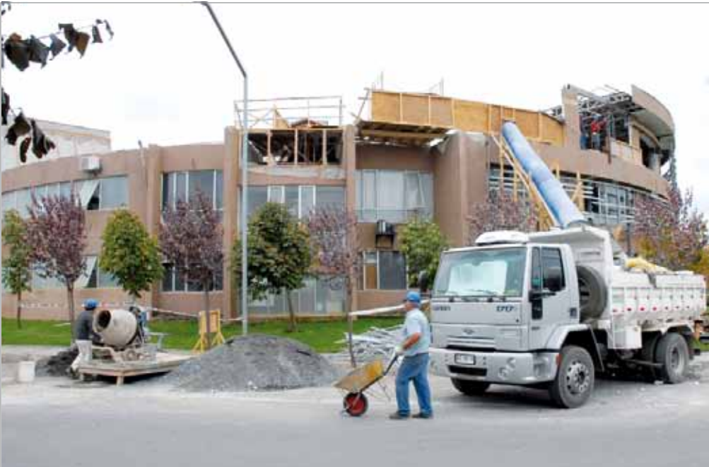
En forma acelerada paralelamente en los tres pisos se trabaja en la recuperación del edificio del Instituto de Biología Vegetal y Biotecnología. El último contrato debe terminar en julio.
