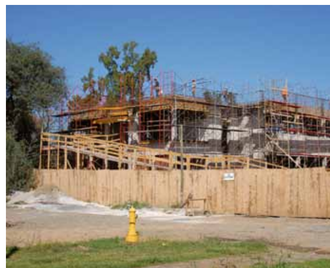
Salas de clases, auditorios y oficinas son algunas de las dependencias que albergará el edificio Aulas Prosperidad 2 en construcción, que contempla 1600 m 2 .
