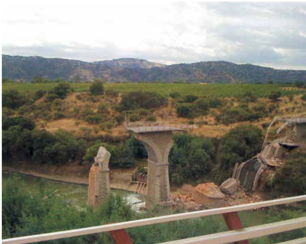
En la imagen, el antiguo puente Río Claro que colapsó durante el terremoto de 2010.
