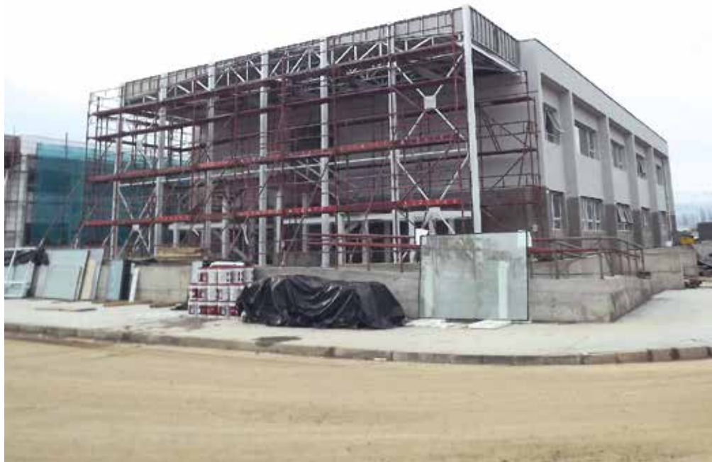
La construcción de estas modernas instalaciones se inició en diciembre pasado y concluirán a comienzos de este 2016.
