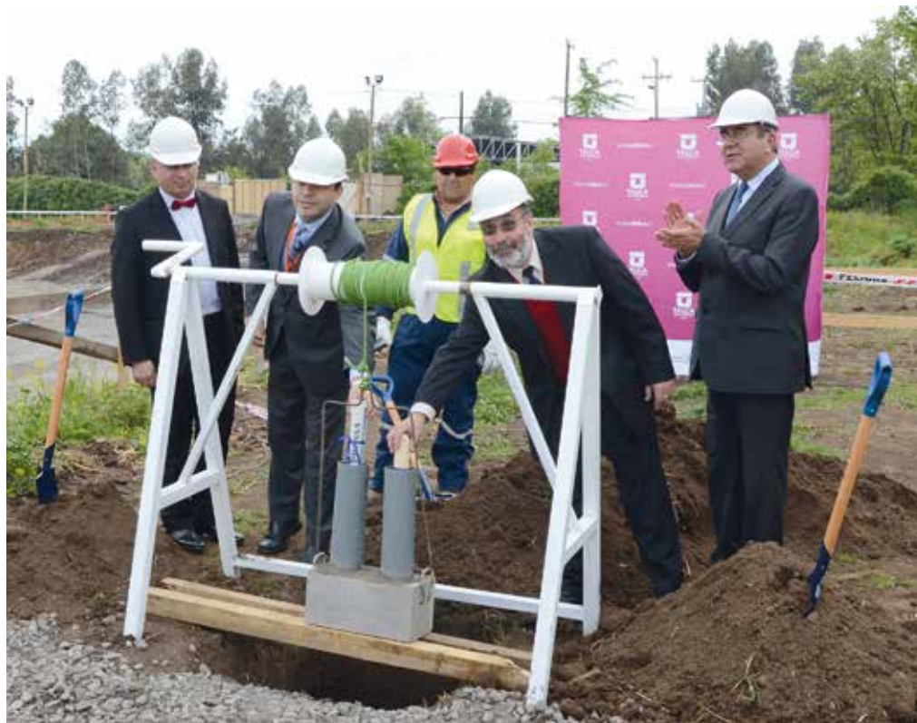
Durante 2017 deberá concretarse la construcción del nuevo edificio.
