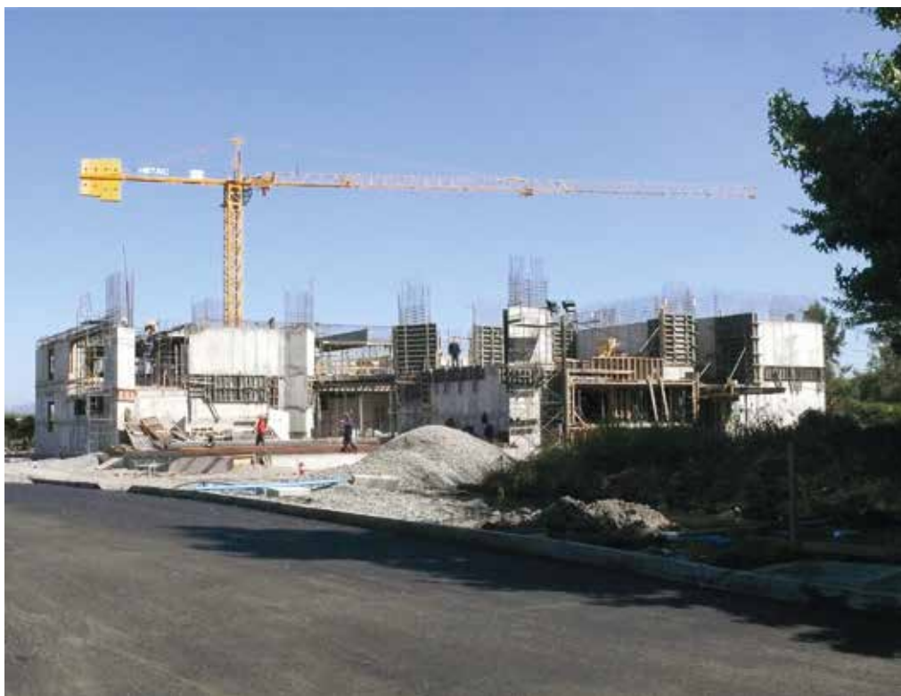
La nueva construcción se sumará al complejo de 12 edificios que se emplazan en el Campus Curicó.
