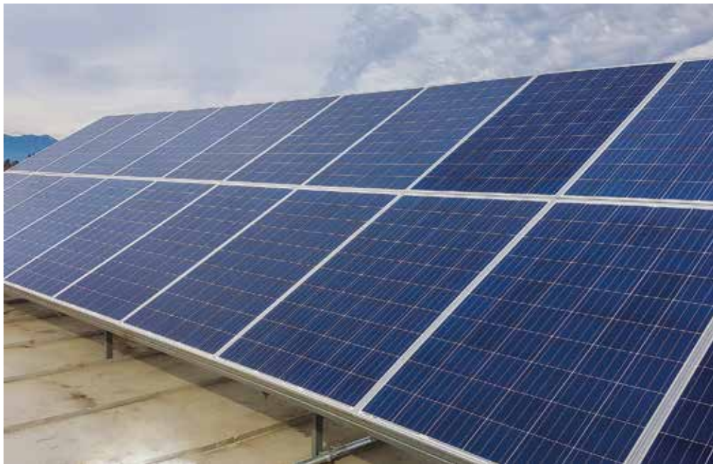
Un nuevo avance en el área de la electrónica de potencia se registra en la Facultad de Ingeniería.
