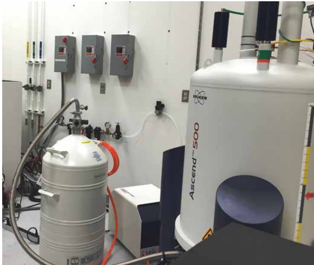
Un resonador magnético nuclear como el de la imagen quedará instalado en el nuevo Centro de Instrumentación Científica Avanzada (Cica) con que contará la Casa de Estudios.
