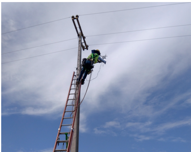
El sistema fue colocado en un sector de la comuna de Romeral y la empresa espera instalar estaciones similares
