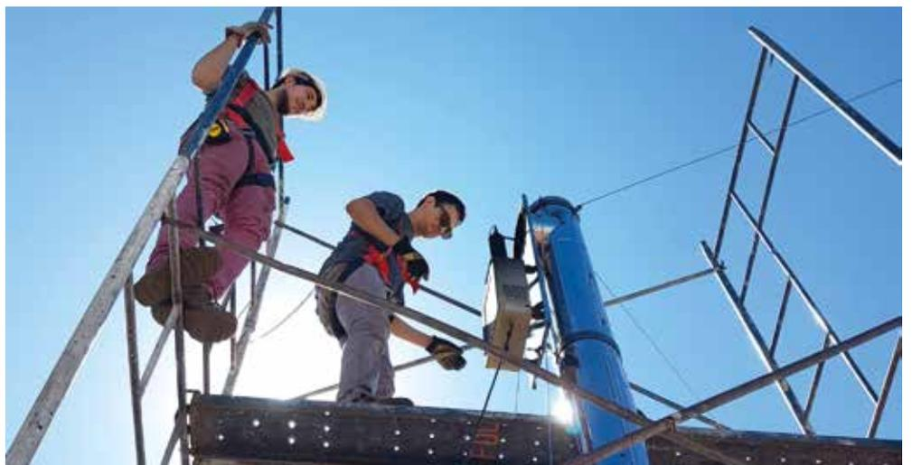
Uno de los sistemas es un extractor de humos que permite acelerar el proceso de encendido de calderas y combustores para que emita menos gases al medio ambiente.
