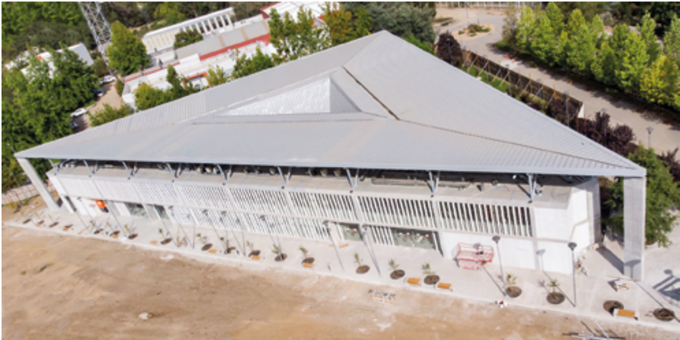
Los edificios del Instituto de Química y el Centro de Instrumentación Científica cuentan con un porcentaje de ejecución cercano al 90%
