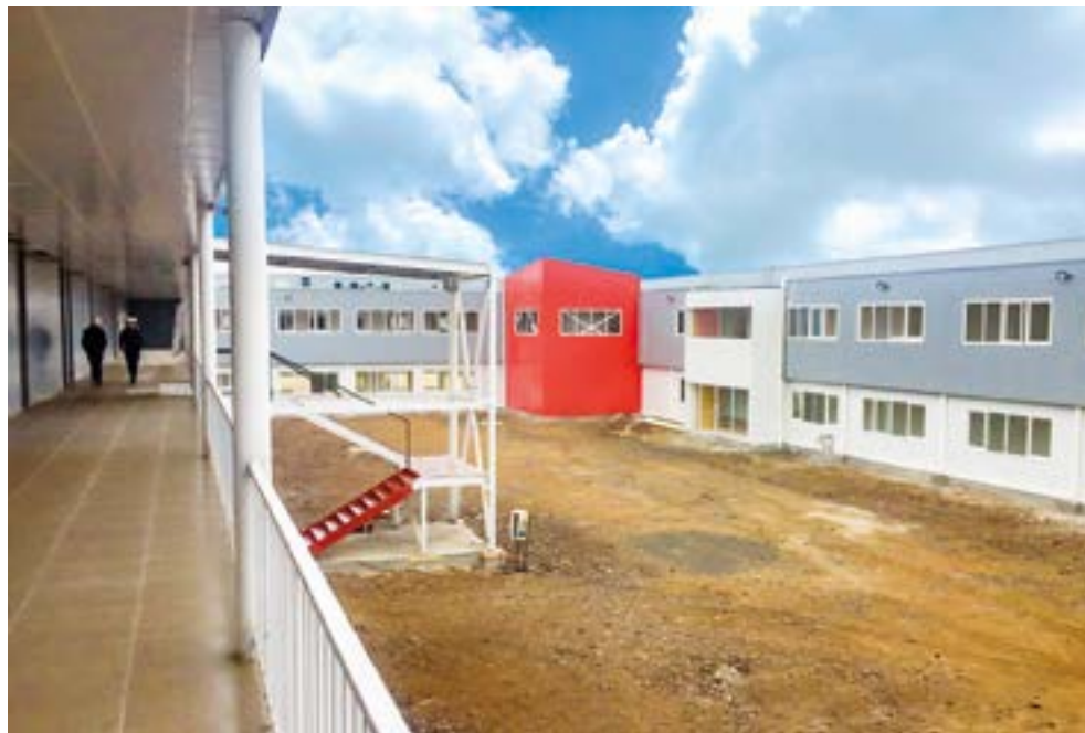
La infraestructura se encuentra en la etapa final de construcción.
