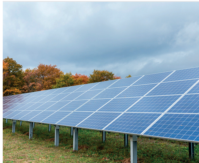
Recientemente arribaron al campus los primeros paneles de la futura Planta.
